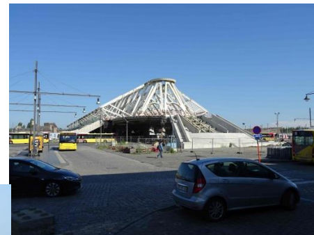
Le chantier de la gare tourne au ralenti.
