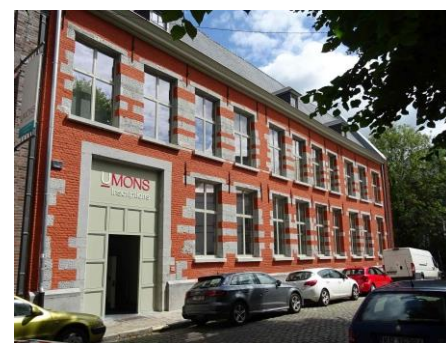
A la place du Parc, les bâtiments de l'UMons font peau neuve.
