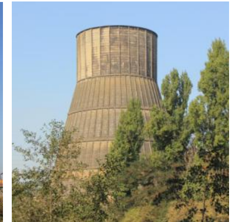
tour de refroidissement
