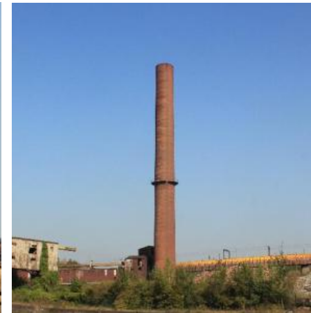
cheminée sur le site Porte Ouest
