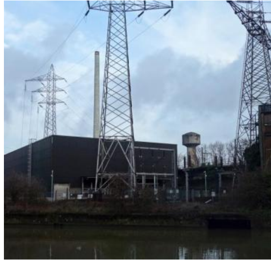
Lignes HT et transformateur électrique
