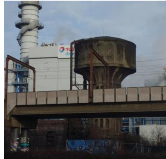
Bruit /fumée de la centrale TGV, N90
