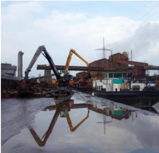
Grues en travail sur le Ravel (Sambre)
