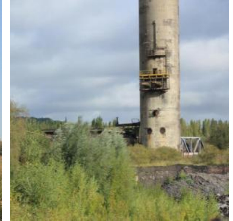
depuis le site Porte Ouest à côté de la cokerie
