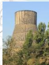
3. Tour de refroidissement
