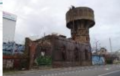
12. Salle des pompes
