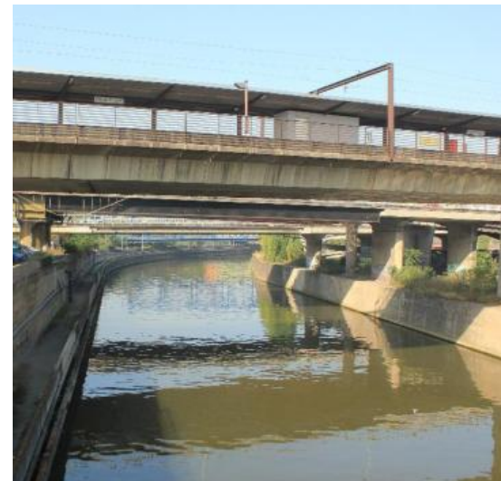
Sambre – berges infrastructurés
