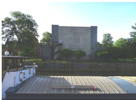
La piscine de Marchienne, fermée et vandalisée depuis des années, devrait être rénovée et rouvrir d'ici 2024.
