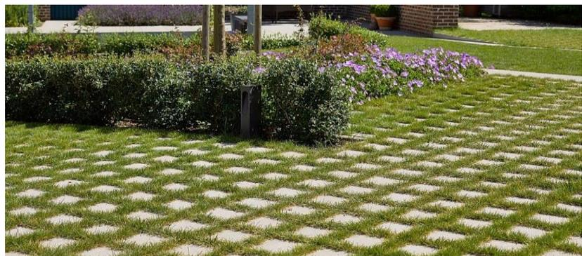
Exemple d'un dallage qui permet à l'eau de s'infiltrer - ©EBEMA
