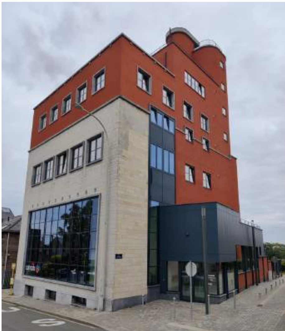
Bâtiment rénové de l'ancienne brasserie. Photo © EE
