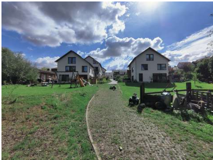
Vue orientée vers le sud-est depuis le jardin. Source : © Espace Environnement.
